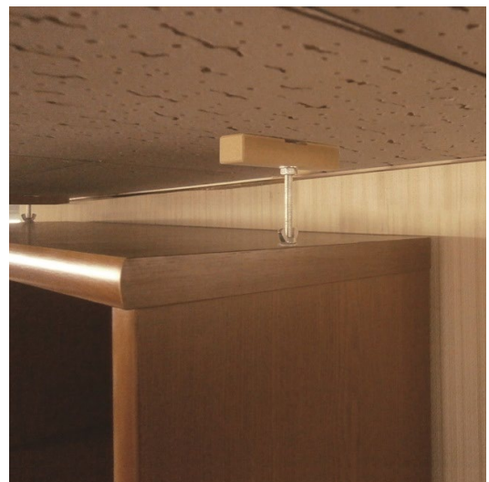
図表 16:製品に組み込まれている耐震補助具
