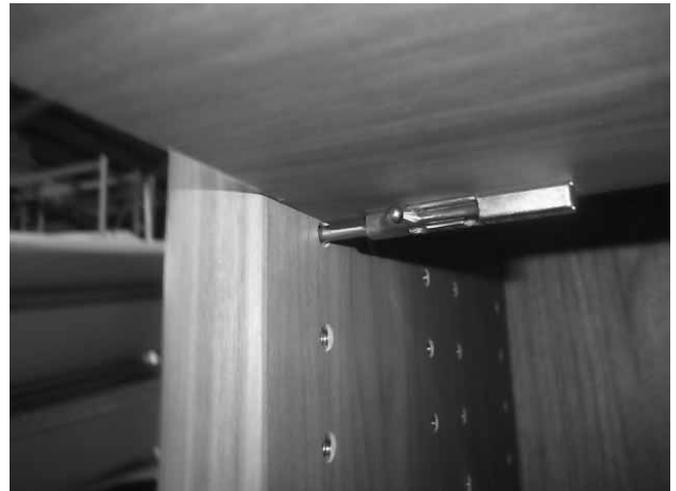
棚板端を持ち上げて、シャフトを差し込んだネジ穴から2段下に付属の金ダボを取り付けてください。この金ダボは棚板が後ろに入らないようにする為のものです。必ず取り付けてください。
